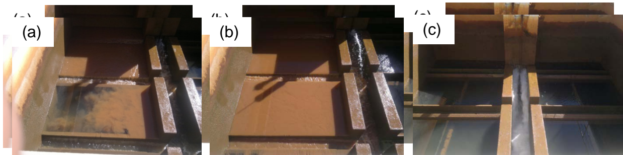
Figura 1 – (a) início da lavagem do filtro, (b) evolução do processo de lavagem e (c) etapa final da lavagem de Filtros da ETA Anápolis.
